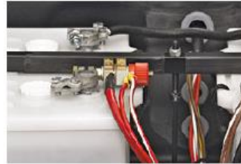
Batterieanschluss am Anhänger wie beim Zugfahrzeug. Rückmeldesignal vom Cargolift wird durch Quetschverbinder hergestellt.
